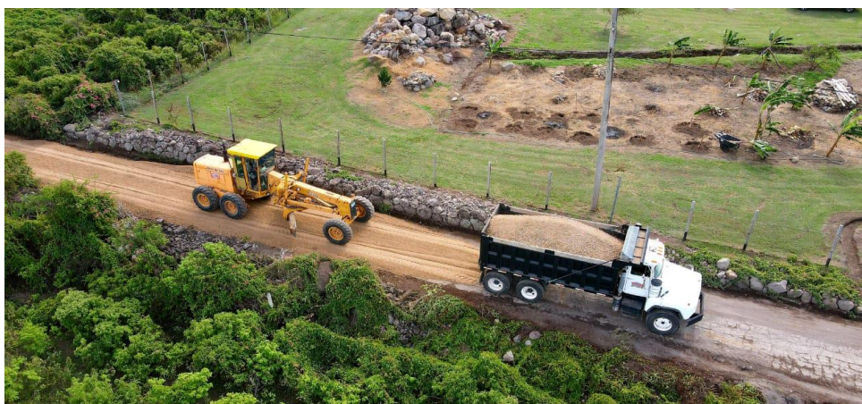
In november hebben tijdelijke werkzaamheden plaatsgevonden om de Road Behind the Mountain voldoende begaanbaar te maken.
